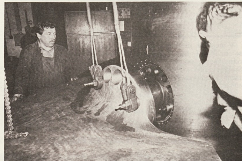
Montaža je uspeša (Foto: T.Š.)
