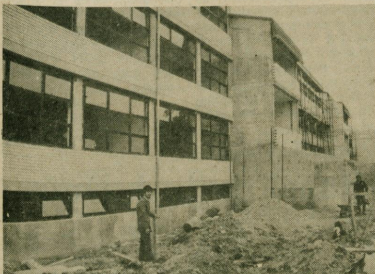
Dela na novogradnji Osnovne šole Vencija Perka hitro napredujejo in šola bo pripravljena za sprejem učencev ob začetku šolskega leta
