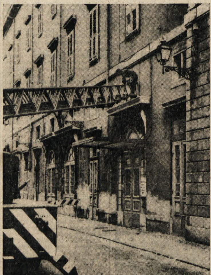
Gasilci odstranjujejo razmajan omet nad stranskim vvhodom v Verdijevo gledališče v U. San Carlo
