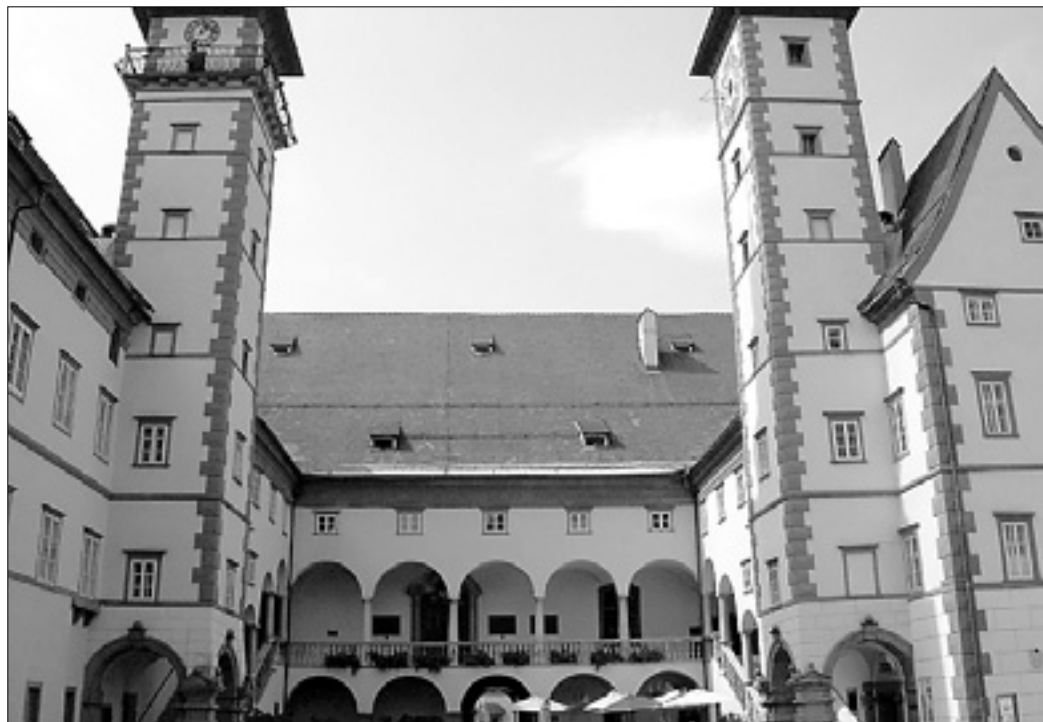
Pogled na deželno palačo v Celovcu
