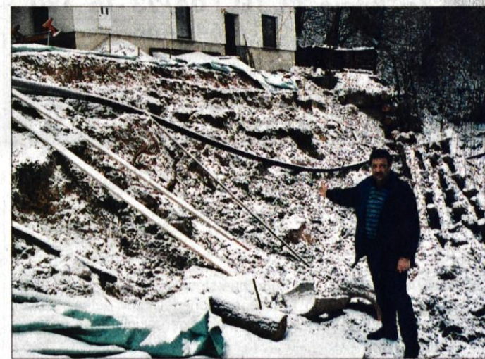
Zemeljski plaz v Zmincu ogroža dve hiši.
