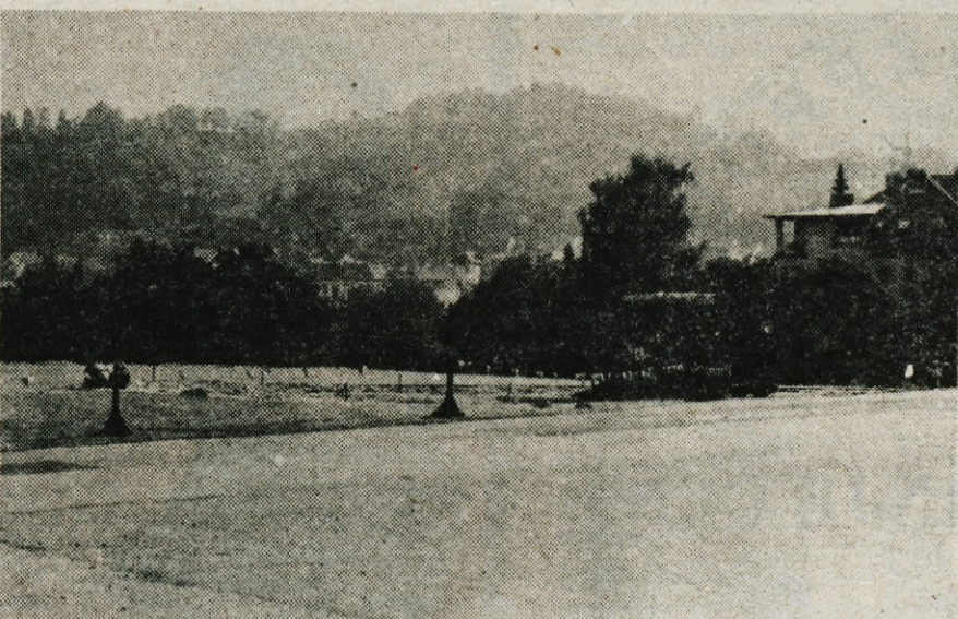
Škofja Loka — Novo križišče pri Petrolu, ki je zgrajeno v obliki enonivojske detelje in je na najbolj prometnem delu Škofje Loke, saj cesta poteka v eni smeri proti Kranju in Ljubljani, v drugi smeri pa proti poljanski in selški dolini, so prejšnji teden prekrili z asfaltom. Križišče za promet še ni odprto. Foto: V. Primožič
