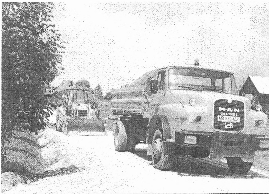
Modernizacija ceste v Vodrancih
