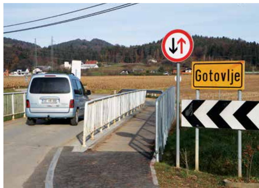
Za večjo prometno varnost za pešce in kolesarje so most čez potok Ložnica razširili.
