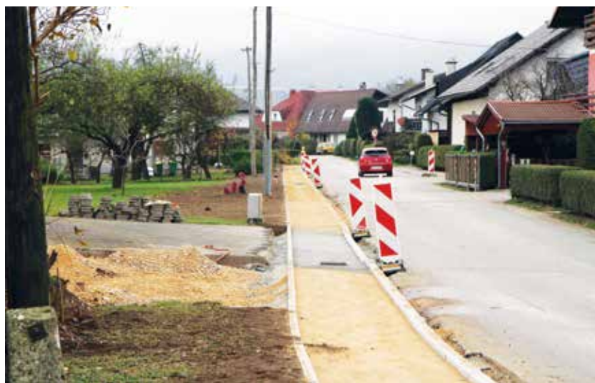
Gradnja prve faze pločnika od Kapelce do Uplaznika bo gotova konec tega meseca. Obenem bo položen nov vod električne napeljave in zgrajena javna razsvetljava.
