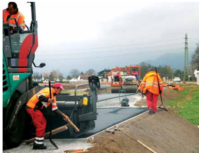
Gradnja povezovalne ceste, ki je v prvih dneh novembra že dobila prvi sloj asfaltno prevleke, drugi sloj pa bodo položili spomladi.
