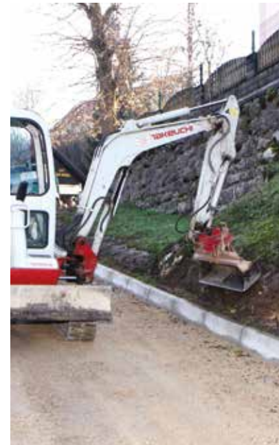
Obnova dovozne ceste
