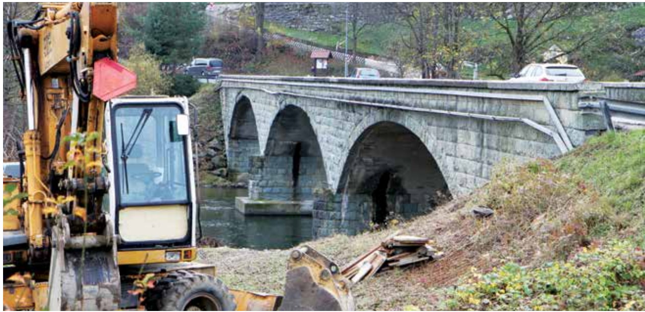
Pripravljalna dela pri obnovi mostu so se že začela.
