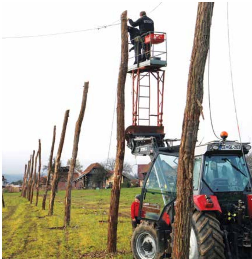
Pri Rojnikovih v Zg. Grušovljah pri postavitvi nove trihektarske žičnice. Zaradi letošnjih neurij bodo morali obnoviti tudi 10 hektarjev obstoječih žičnic. Strošek obnove in nove žičnice bo po besedah Rojnikovih okoli 70 tisoč evrov.
