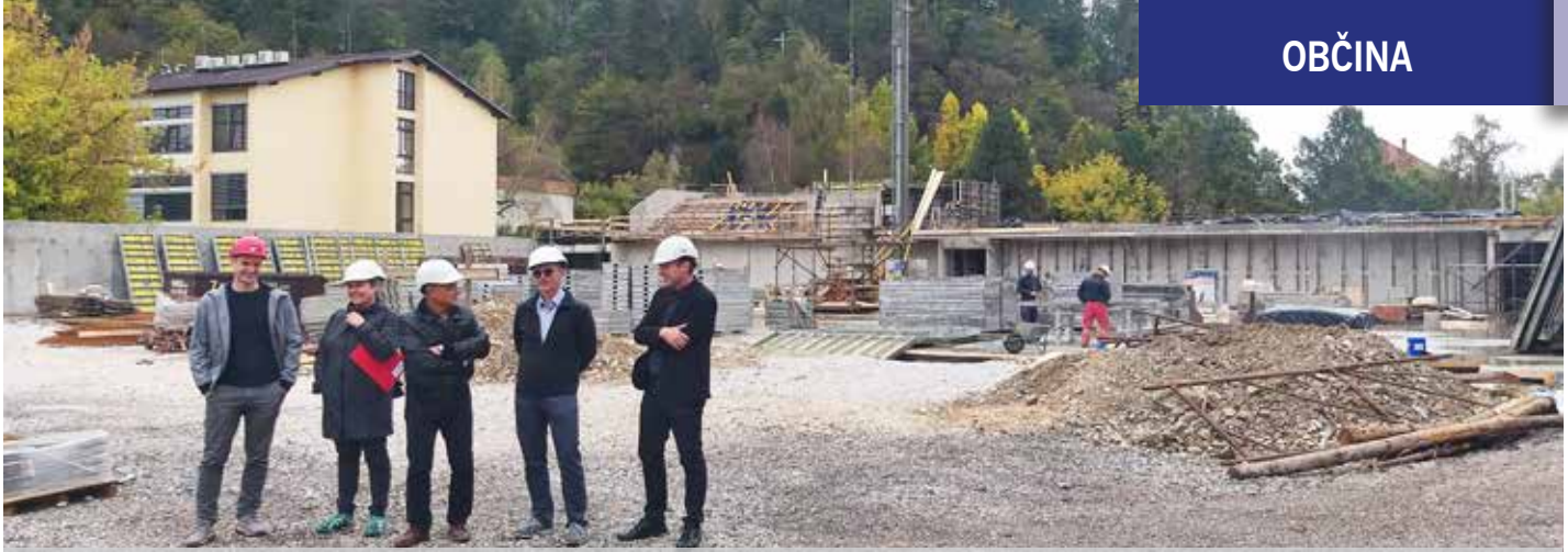
Nejc Vozelj, vodja gradnje nizkoenergijske večnamenske Športne dvorane Mengeš pri SGP Graditelj, d. d., Maja Skale, svetovalka za področje športne infrastrukture, mag. Darko Repenšek, vodja Sektorja za razvoj športa in športne infrastrukture (oba Direktorat za šport), Milan Burkeljca, ravnatelj Osnovne šole Mengeš, in Uroš Drobež, vodja investicij na Občini Mengeš, so si ogledali stanje na gradbišču in načrte za nadaljnjo gradnjo.
