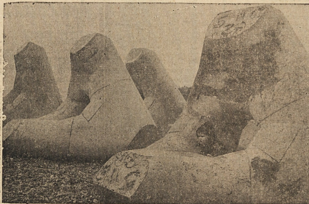
TANKOVSKJE OVIRE? — Velikanski bloki betona na obali pri Shorehamu na Angleškem, kot jih vidimo na sliki, bi lahko služili tudi za ovire tankom. Dejansko so bili postavljeni tja, da varujejo obalo pred močnimi valovi morja.
