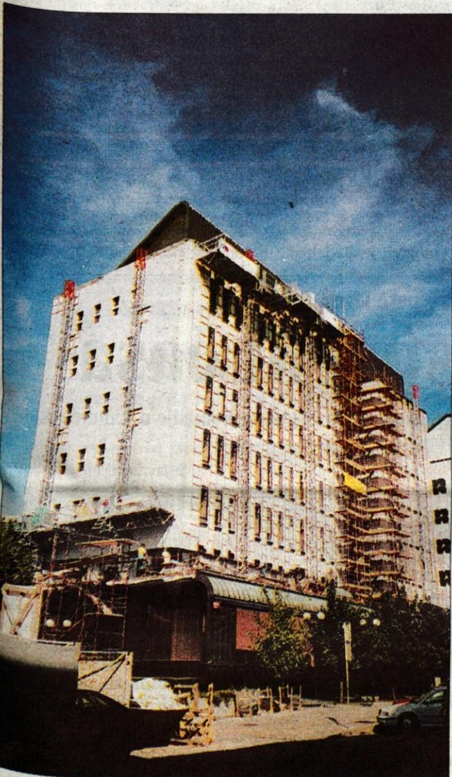
Gorenjska banka obnavlja fasado poslojpa v Kranju.
