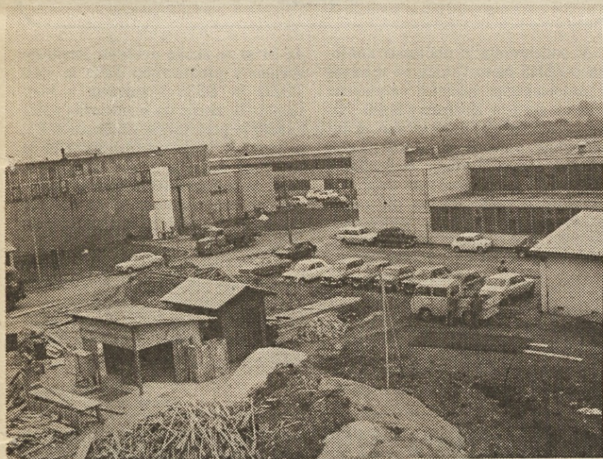
Stegne so letos eno samo gradbišče.
