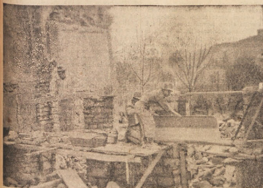
Obnova porušenih hiš na Cesti pri Ajdovščini.
