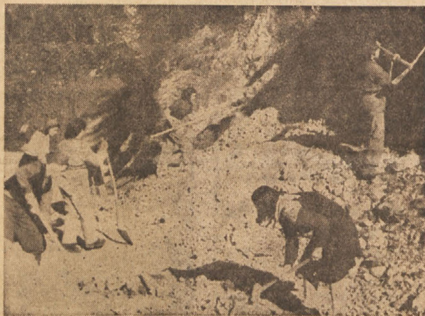
Gradnja ceste v Nemški Rut.
