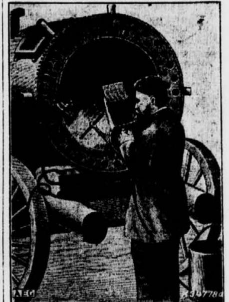
Nikolas von Benardos bei einer Ausbesserungsarbeit mit seiner Lichtbogenschweißapparatur.
