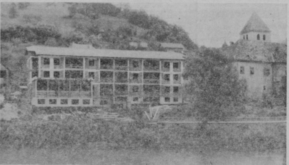
Takole. Dom ali hotel za upokojence v Laškem je pod streho. Vanj se bodo že letos lahko vselili njegovi stanovanjci, med Laščani pa se je razvila besedna bitka, ali je lep in vklopljen v okolje ali ne. Podrli ga menda ne bodo zato?
