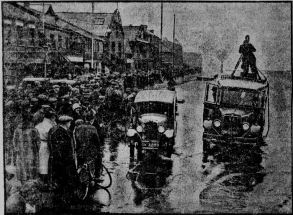
Velike poplave na Angleškem. Silne nevihte so zadnje dni povzročile na Angleškem velike poplave. Reka Temza je povsod prestopila bregove in poplavlja blizu ležeče kraje. Na sliki vidimo poplavo pri Putneyu.
