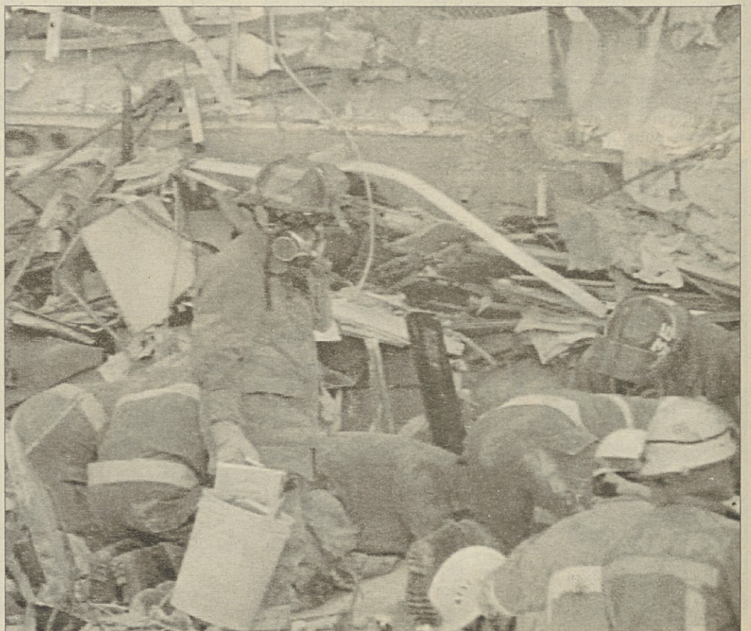
Gasilci pod ruševinami zvezne zgradbe iščejo trupla in morebitne preživele (Telefoto: AP)
