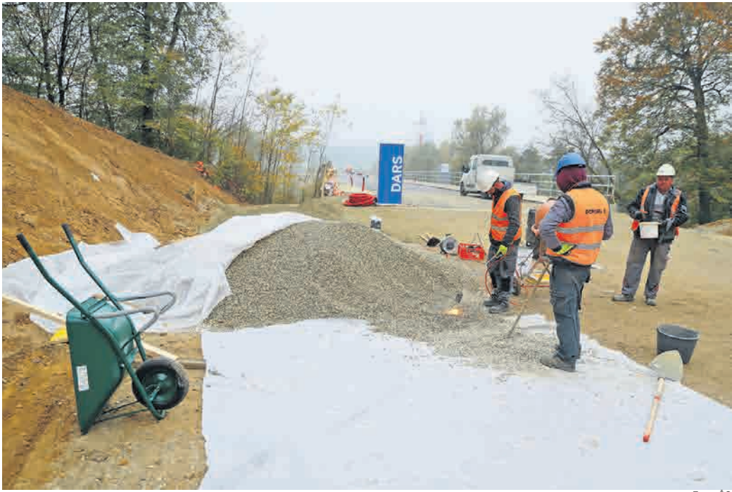
Po besedah Alenke Muhič iz Darsa je na gradbišču vsak dan okoli 50 delavcev. „To omogoča sledenje terminskim planom gradnje. Nekatera dela so pripravljala, druga pa že v sklopu projekta, recimo izvedba propustov.“
