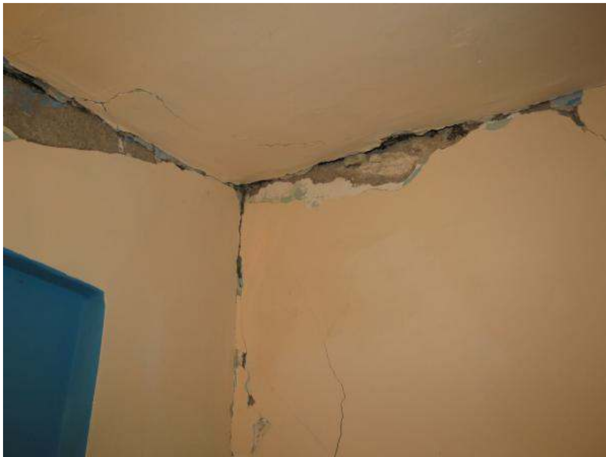
Slika 3. Široke in globoke razpoke na stičiščih nosilnih sten in stropov (foto: Matjaž Godec)
