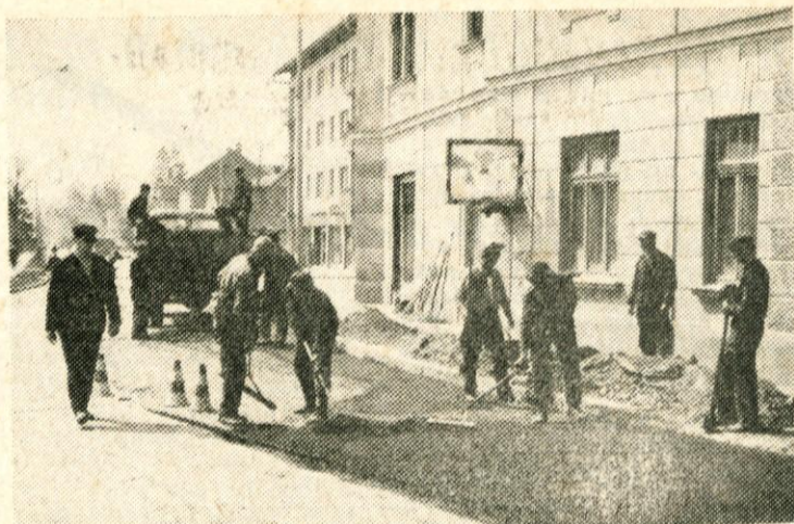
Novo domžalsko komunalno podjetje, ki je nastalo z združitvijo Cestnega podjetja in Vodovoda, se je letos resno lotilo popravila na nekaterih krajih močno poškodovanega asfaltnega cestišča. Dela so sedaj v glavnem že opravljena, vendar Ljubljanska cesta v Domžalah že kaže, da jo bo treba v celoti prevleči s še eno plastjo asfalta
