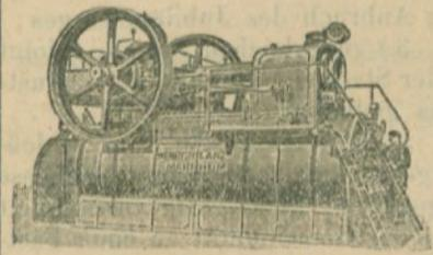
**Amtliches Prüfungsattest**, vorgenommen an einer 100 P. S. Heißdampf-Compound-Lokomobile mit Kondensation und Ventilsteuerung System „Lentz“:
