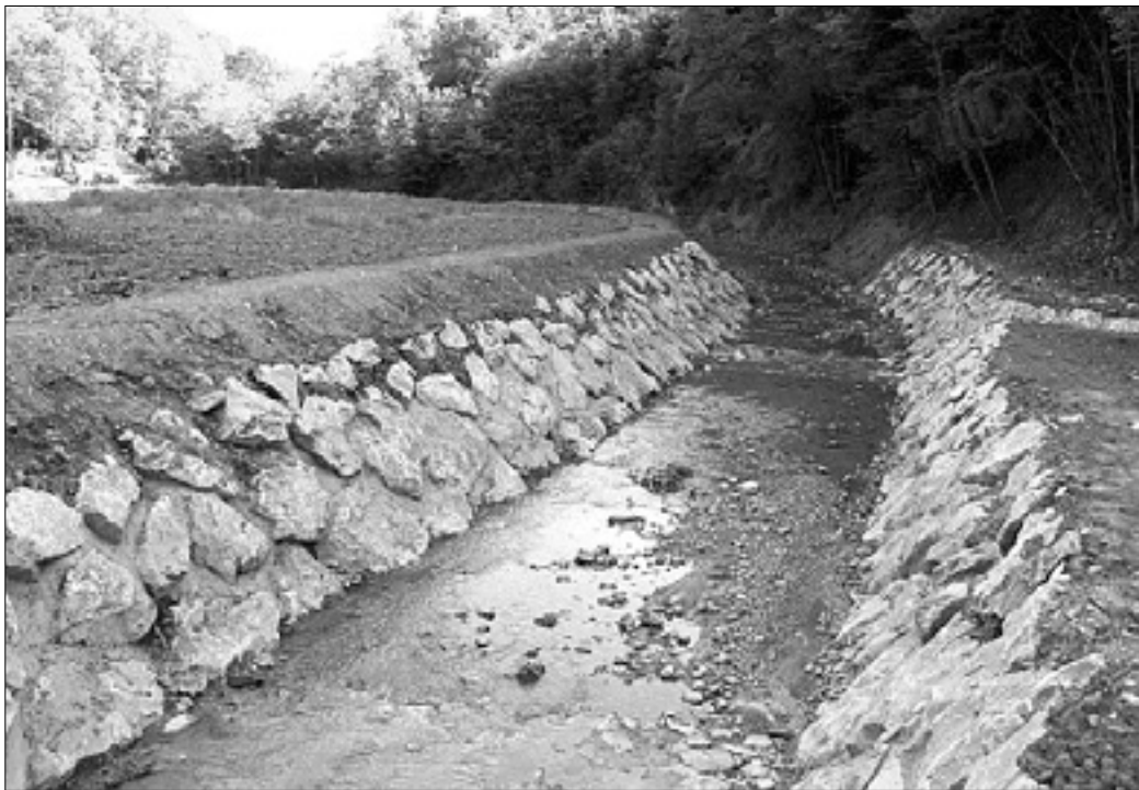
Utrjeni bregovi Grojnice pri mostu za v Aščeve
