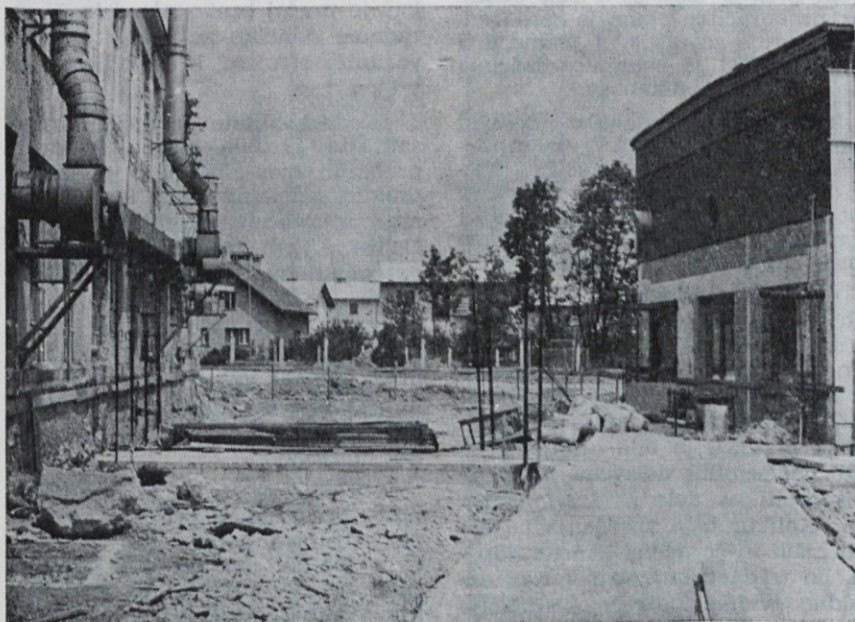
Gradbišče veznega hodnika
