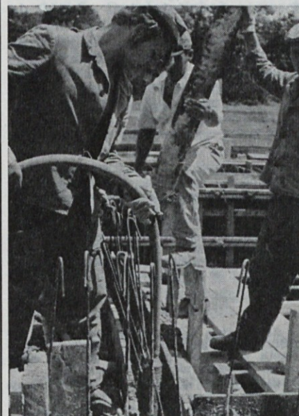
Uporaba vibratorja pri betoniranju
