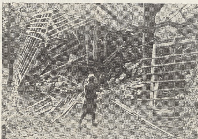
Takole je plaz prestavil hlev Antona Prosenca iz Zapedja. Zidovje je pogoltnila zemlja
