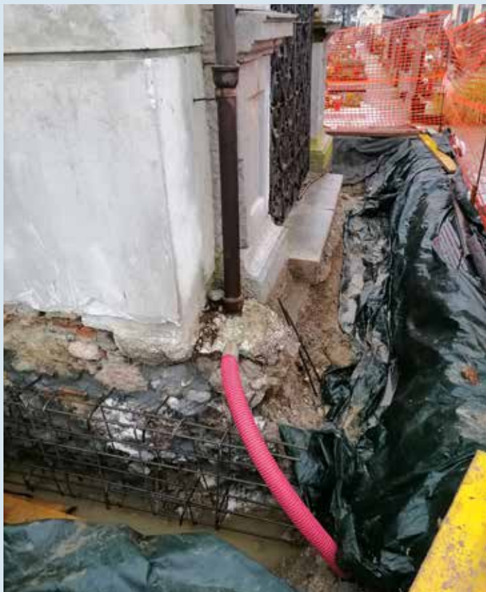
Konservatorsko-restavratorska dela na mali grobni kapeli rodbine Stare so se začela v mesecu novembru in se bodo zaradi obsežnosti in zahtevnosti del izvajala po segmentih v daljšem časovnem obdobju.
