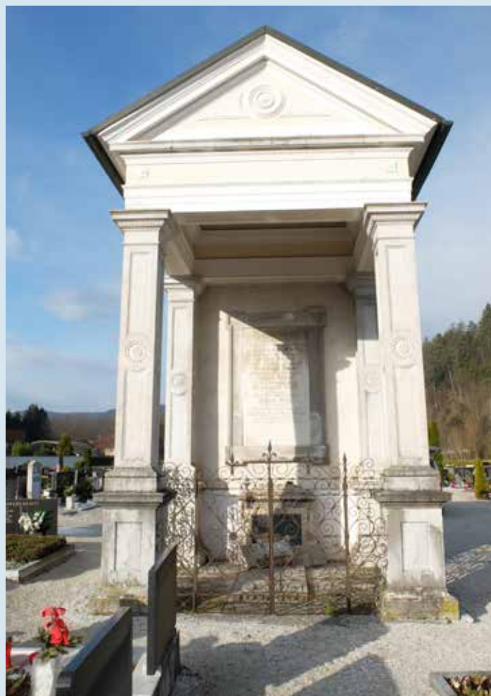
Po ogledu sta Jaka Grmek in Ana Resnik pripravila program dela, ki ga bodo v dogovoru z odgovorno konservatorko dr. Renato Pamić med izvedbo konservatorsko-restavratorskih del po potrebi spreminjali oziroma dopolnjevali glede na poškodbe spomenika.
