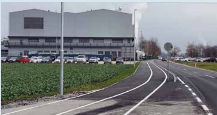
Občina Mengeš je v letu 2021 pristopila k urejanju oziroma izgradnji kolesarske povezave in pločnika od Kolodvorske ceste do podjetja Lek in tako lahko sedaj tudi pešci in kolesarji iz občine Mengeš varno dostopajo do delovnega obrata družbe Lek.
