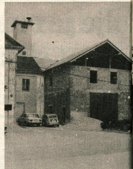
Do jeseni nameravajo v prizidku gasilskega doma dokončati orodjarno
