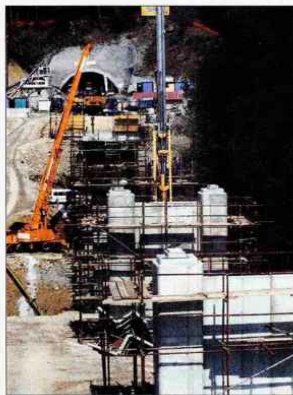
Gradnja 316 metrov dolgega viadukta Ljubno
