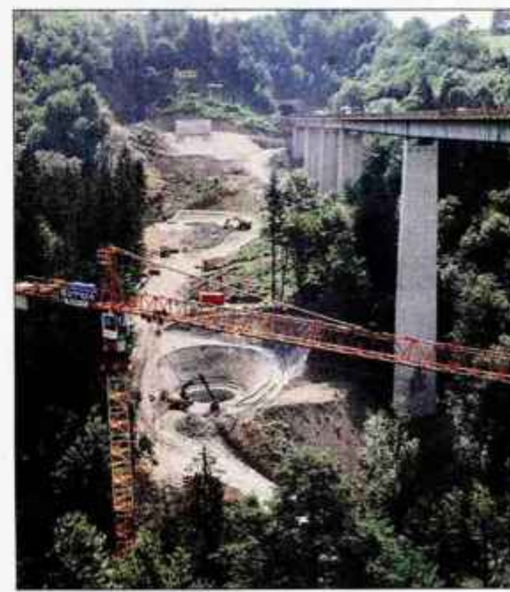
Pogled na temelje novega viadukta Peračica
