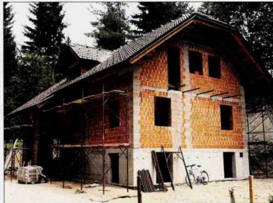
Dom veteranov je že pod streho.
