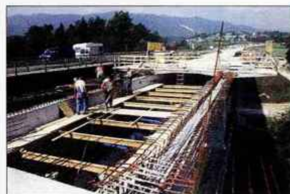
Viadukt Lešnica so narivali z obeh strani, potem ga je bilo treba na sredini še spojiti.
