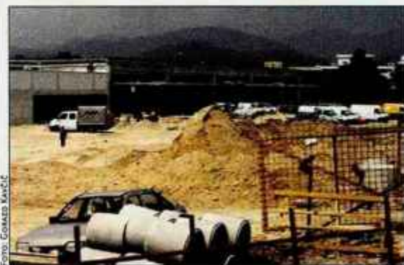
Gradnja Mercatorjevega in Merkurjevega trgovskega centra
