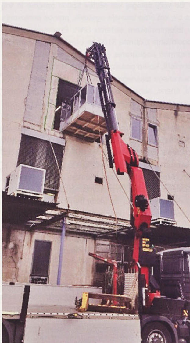
Dvig strojev v nadstropje
