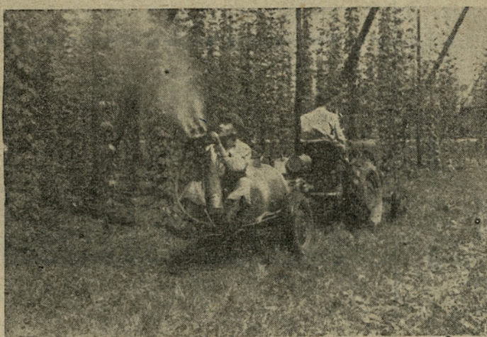
Škropljenje hmeljišč z molekulatorjem. Molekulator porabi 5-krat manj vode za enak učinek, zato je delo z njim hitro in lažje.
