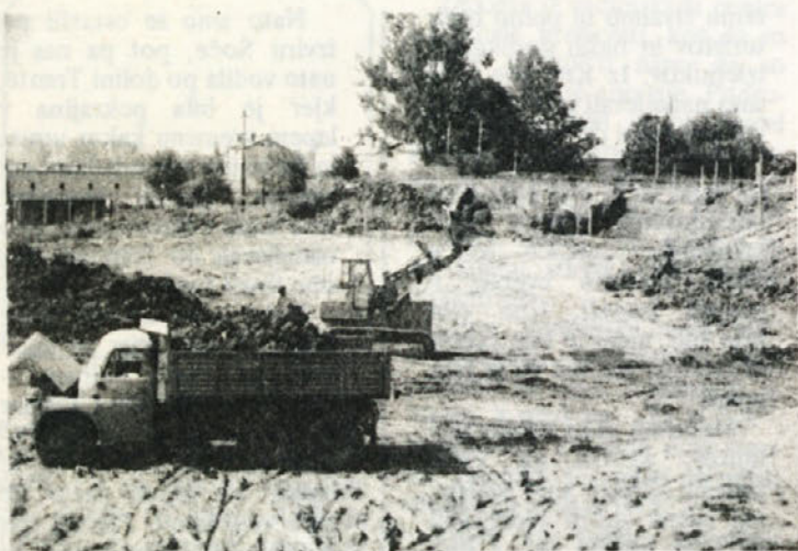
Zemeljska dela za izgraditev nove kodranke so v polnem zamahu. Novi proizvodni prostori bodo zajemali enajst tisoč kvadratnih metrov površine. Buldožerji pa rijejo tudi na severnem delu, kjer bomo uredili športna igrišča. Foto: Branko Herak
