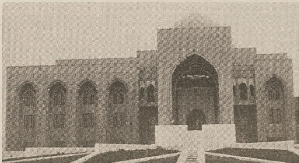
Huseinova palača v puščavi
