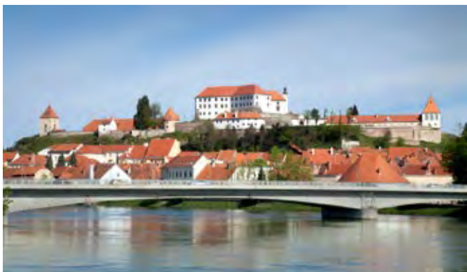
Grajski kompleks nujno potrebuje tudi požarni hidrant.
