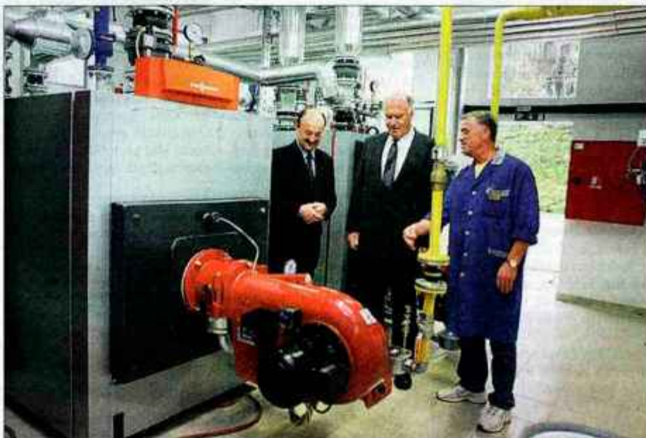
Nova plinska kurilnica je stala 110 milijonov tolarjev, ogrevala pa bo tudi prizidek, ki ga bodo zgradili prihodnje leto.
