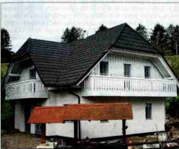
Jelovica je montažno hišo že postavila v Vodenici pri Bovcu.
