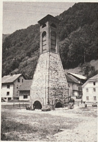
Plavž v Železnikih, nema priča nekdanjega dela fužinarjev.
