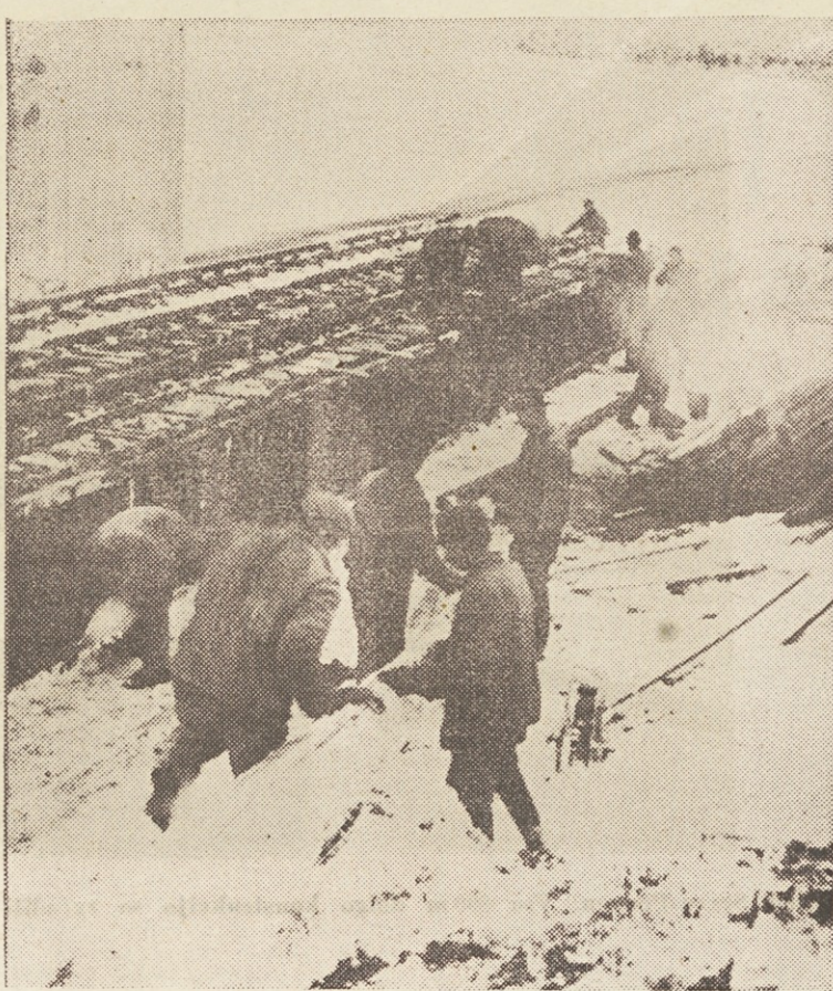
Sneg in mraz ne zmanjšujeta delovnega elana. Betoniranje na Srednji Dravi
