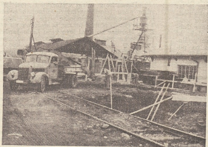
Izkop temeljev za novo kotlarno v Mariboru
