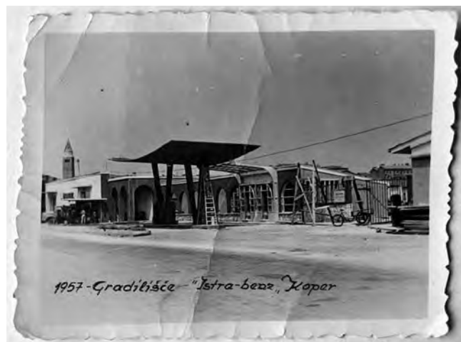
Bencinski servis Koper 1 in upravna stavba s skladišči v Kopru pri Mudinih vratih ob koncu gradnje leta 1957 (Hrani družina Vodopivec)
