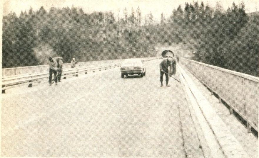
Čiščenje zimske nesnage — Zimski meseci so pustili na viaduktu Peračica obilo nesnage, ki jo te dni odstranjujejo delavci Cestnega podjetja Kranj (jk) — Foto: J. Zaplotnik
