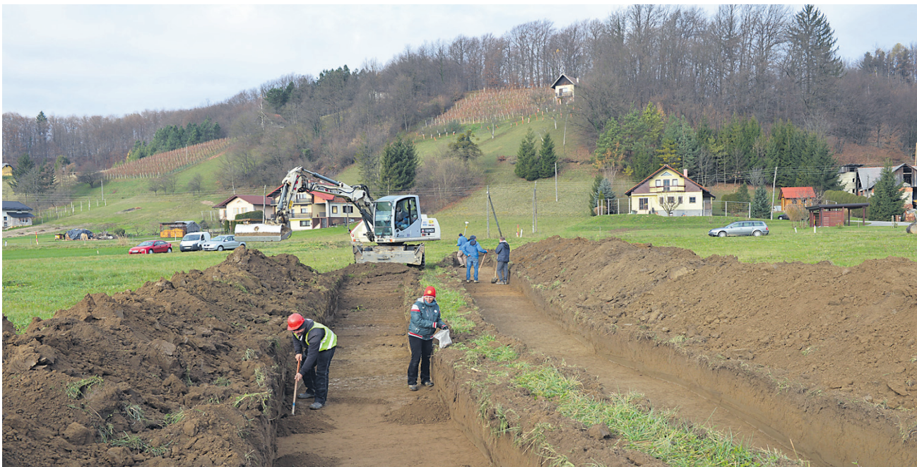
Z delovišča pri Novi cerkvi; po tem, ko strojno odstranijo vrhno plast, poteka delo le ročno, z lopatami, motikami, žličkami in čopiči.
