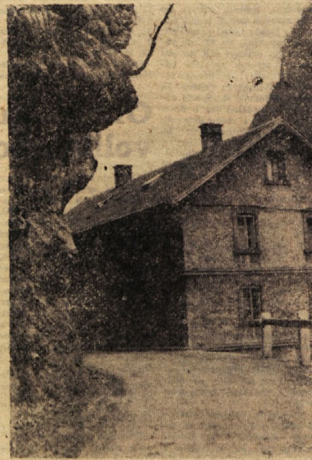
Cesta iz Hrastnika proti Dolu je precej nevarna, največja nevarnost pa je tale nepregledni ovinek
