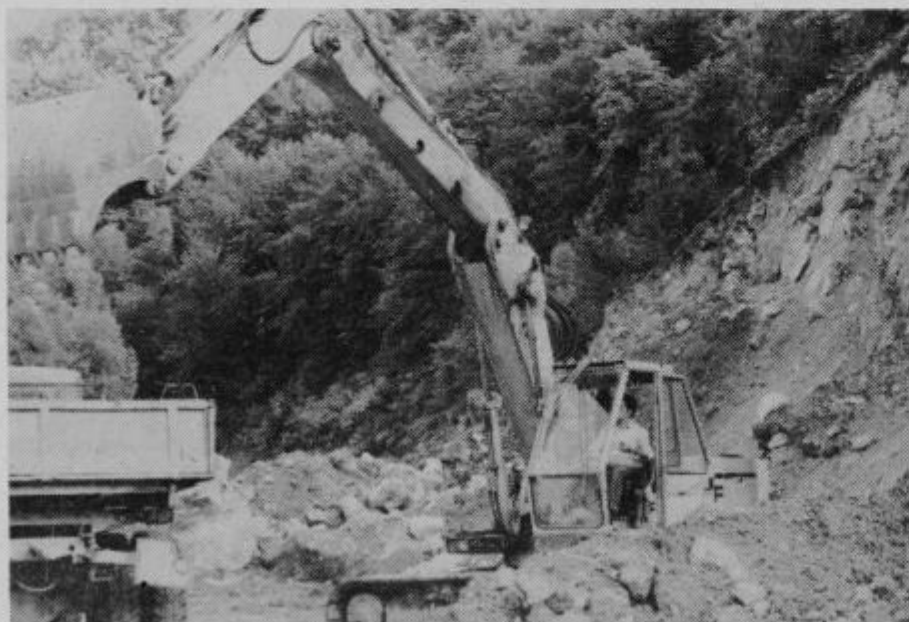
Z moderno mehanizacijo mlade roke vojakov odstranjujejo težke ovire, ki se pojavljajo na novo nastajajoči cesti Tržišče-Boštanj v dolžini enajst kilometrov!
