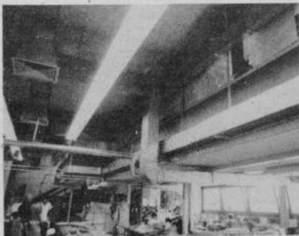
Kovinska konstrukcija v tovarni KORS
