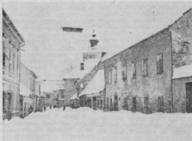
Popravila je potrebna tudi fasada, katere odpadli omet spominja na prejšnje stoletje.
