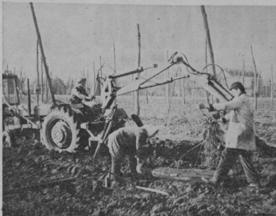
GRADNJA NOVIH ZICNIC — Pri Kmetijskem kombinatu »Hmezd« Zalec bodo letos spomladi obnovili okoli 80 ha hmeljskih žičnic. Lani jeseni pa so jih obnovili že okoli 30 ha. Nove žičnice bodo lesene ter pol metra višje kot sedanje, to pa predvsem zato, ker bo v teh hmeljiščih nova sorta hmelja atlas ali pa aurora. Na sliki: dela pri gradnji žičnice v Sempetru. Tekst in foto: T. Tavčar
