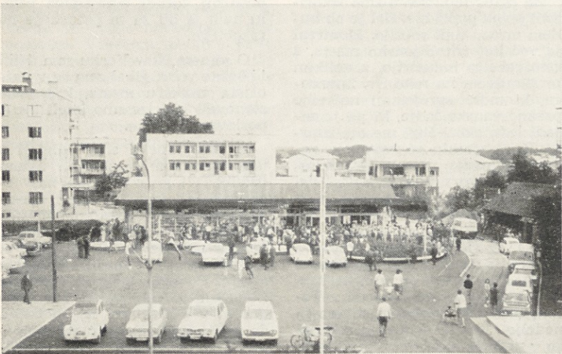
Za čas, ko so potekala dela asfaltiranja in preurejanja dvorišča pred restavracijo, se je glavni promet odvijal na ploščadi med upravnim poslopjem in trgovino Mercator
