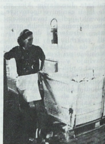
Leseni zaboj ni vzdržal teže vreten prstančnega stroja Igolstadt. Remontnemu delavcu ali transportnemu delavcu se je zaboj z vreteni zagozdil med motorjem prstančnega stroja in steno oddelka.
