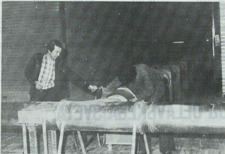
Tako priključimo komorno rezkalo na glavno transportno cev. S pritiskom na stikalo se komorni rezkar premika po tirnici v vzdolžni ali prečni smeri v določeno smer. Delovanje rezkarja je avtomatsko.
