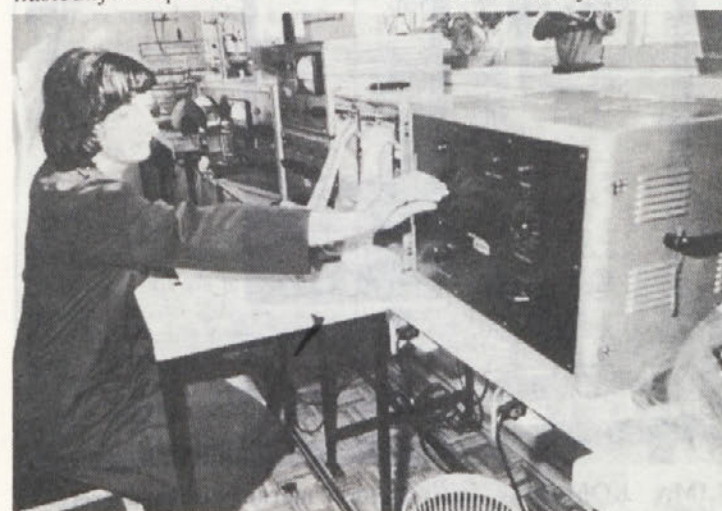
Kontrola neenakomernosti prepreje in preje, ki se izvaja v predilnici na „Uster“ aparatu.
