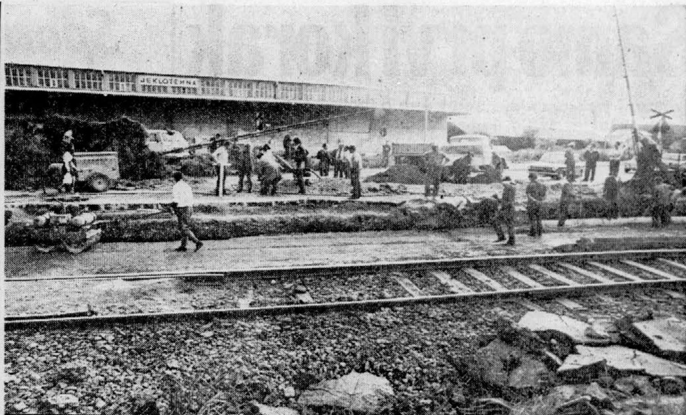
ELEKTRIFIKACIJA PROGE — Od torke do četrtka je bil zaprt del Ptujске ceste v bližini železniškega križišča, ker so preurejali železniško progo, ki jo bodo v kratkem elektrificirali. Foto: B. Cerin
