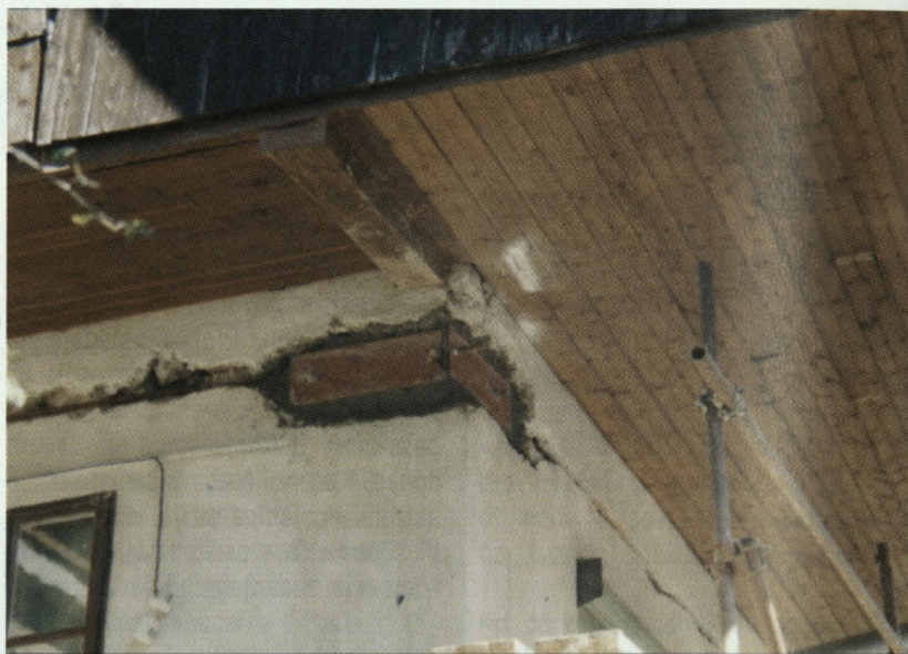
Slika 4: Izvajanje obojestranske zidne vezi – detajl vogala. Po končani obnovi so ti posegi nevidni, v celoti se ohrani arhitektura objekta.
