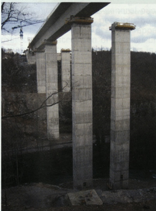
Slika 9: Narivanje prve polovice objekta preko 62 m visokih stebrov
