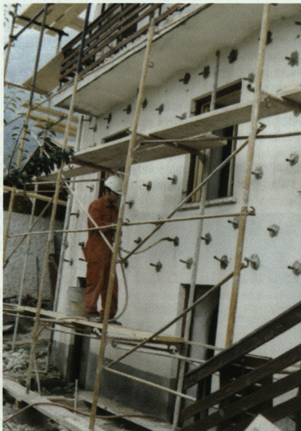
Slika 3: Detajl sistematičnega injektiranja zidov.
