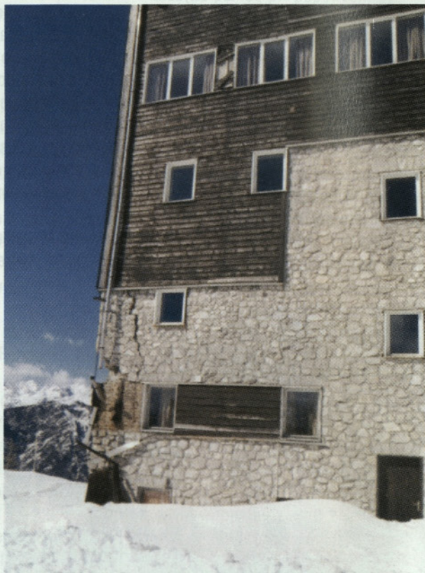
Slika 5: Ski hotel Vogel – med najhuje poškodovanimi objekti. Zaradi torzije so bili praktično porušeni kamniti nosilni zidovi kleti in pritličja na jezerski strani tlorisa.
