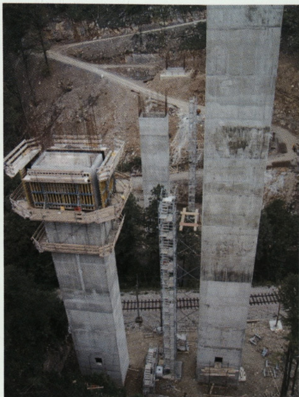
Sliki 7a in 7b: Dnevnoje sta dva stebra napredovala za takt dolžine 3.9 m
