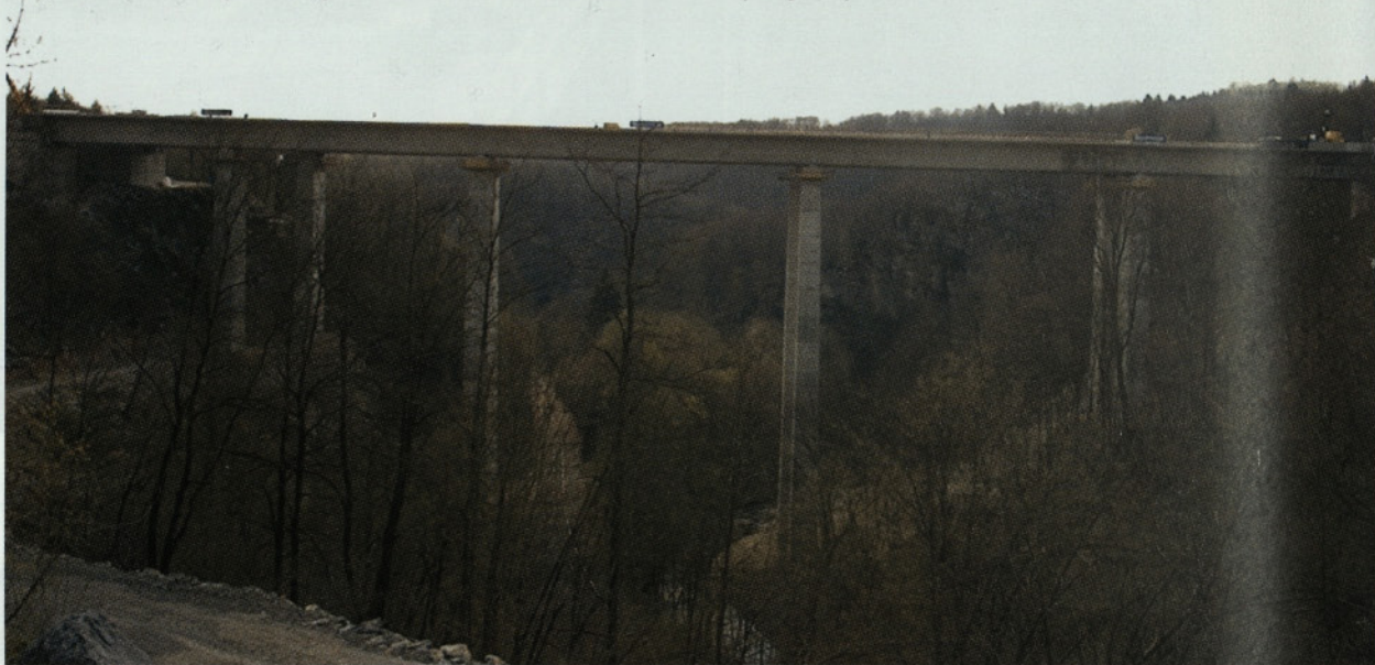
Slika 12: Videz končane konstrukcije obeh polovic mostu v marcu 2003
