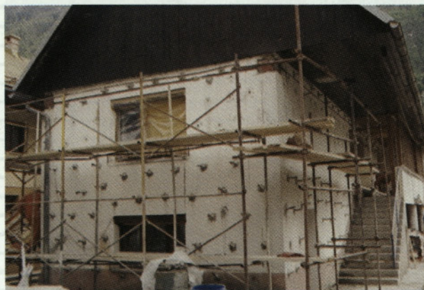
Slika 2: Povezovanje zidov z jeklenimi vezmi in sistematično injektiranje kamnitih zidov.
