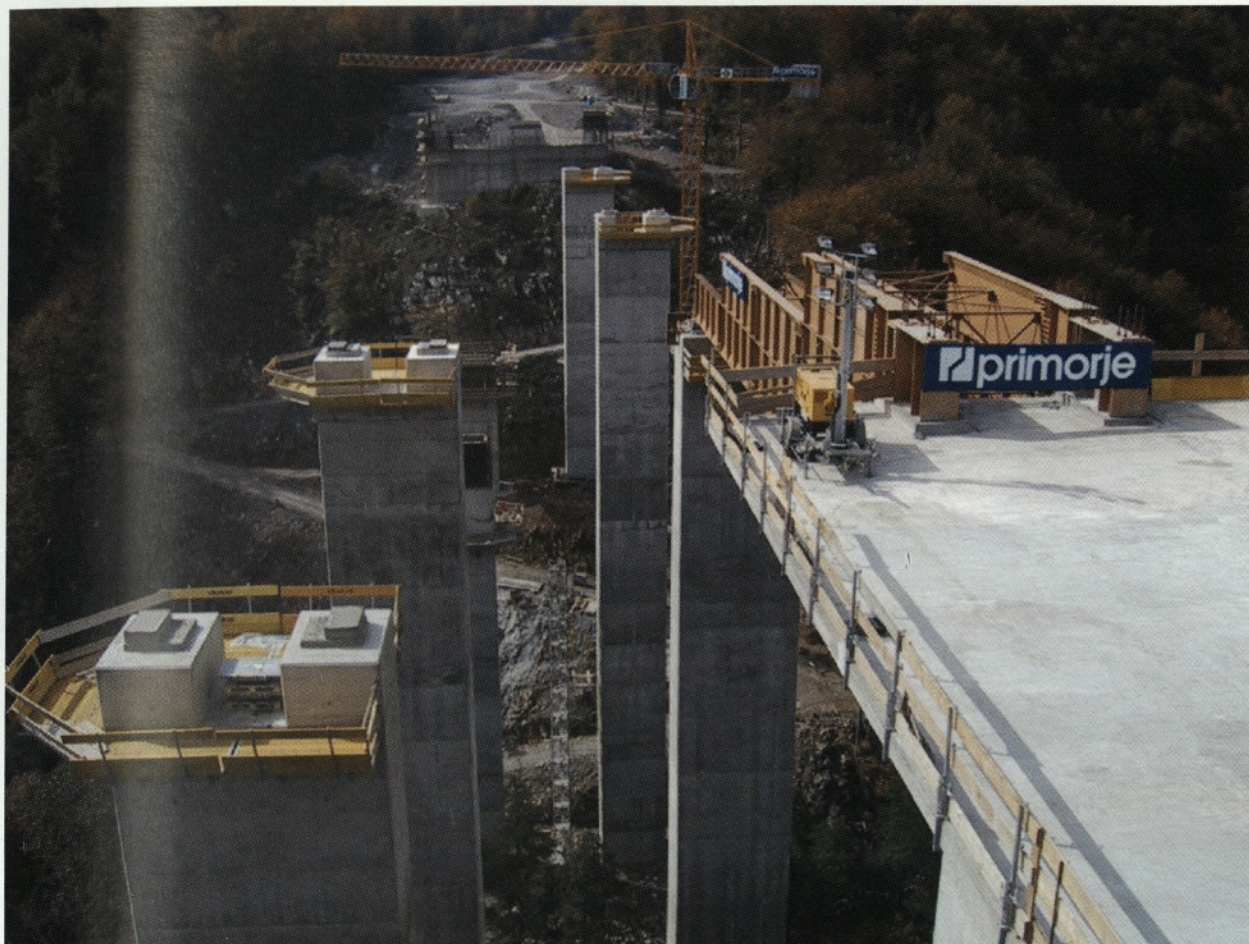
Slika 9: Narivanje prve polovice objekta preko 62 m visokih stebrov
