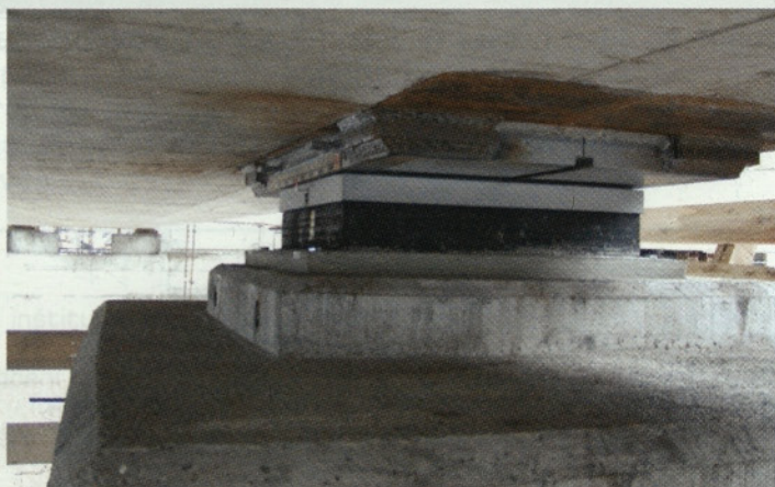
Slika 11: Videz vgrajenega posebnega ležišča s slike 5 pred končno antikorozijsko zaščito
