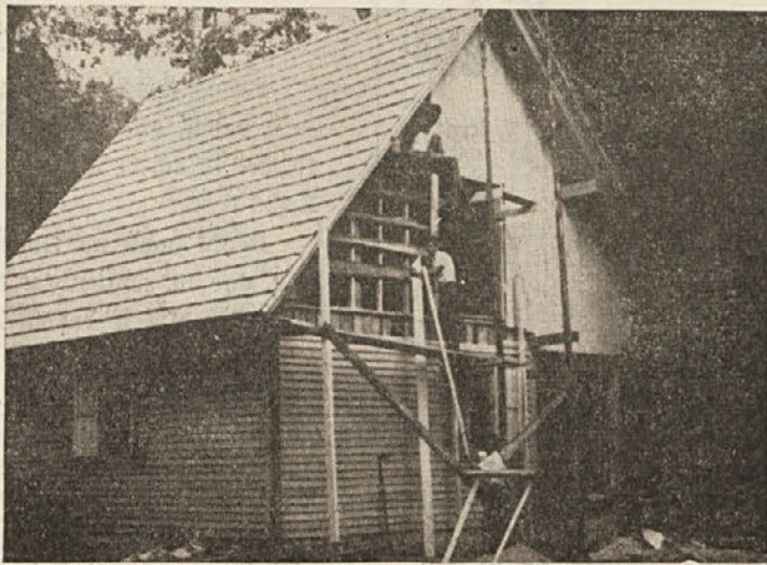
KOČA PRI FRANCETOVI JAMI MED GRADNJO
