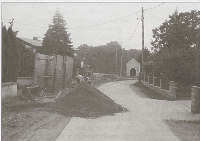
Jeseni se v občini Hajdina nadaljuje izgradnja kanalizacijskega sistema – iz Sp. Hajdine proti centru občine na Zg. Hajdino. Povezava naj bi bila narejena še do konca tega meseca.
