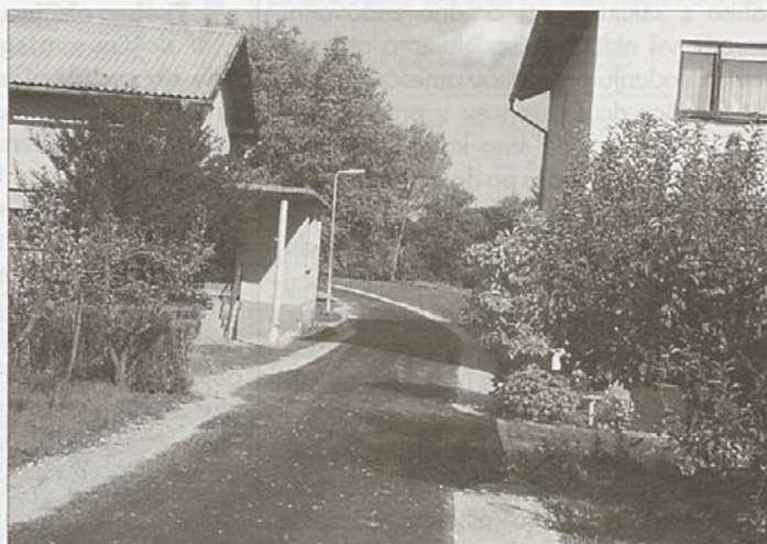
Vzorno urejen cestni odsek Metličar v Slovenji vasi, ki je zdaj dan v javno dobro, poleg asfalta pa so tamkajšnji občani dobili še nekaj luči javne razsvetljave.
