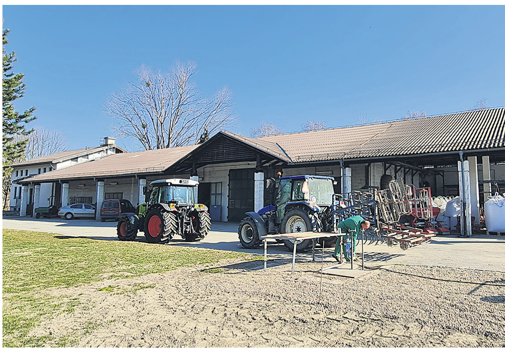
Poslovna stavba potrebna temeljite obnove, v skladiščnih in garažnih prostorih je kup zastarelih strojev.
